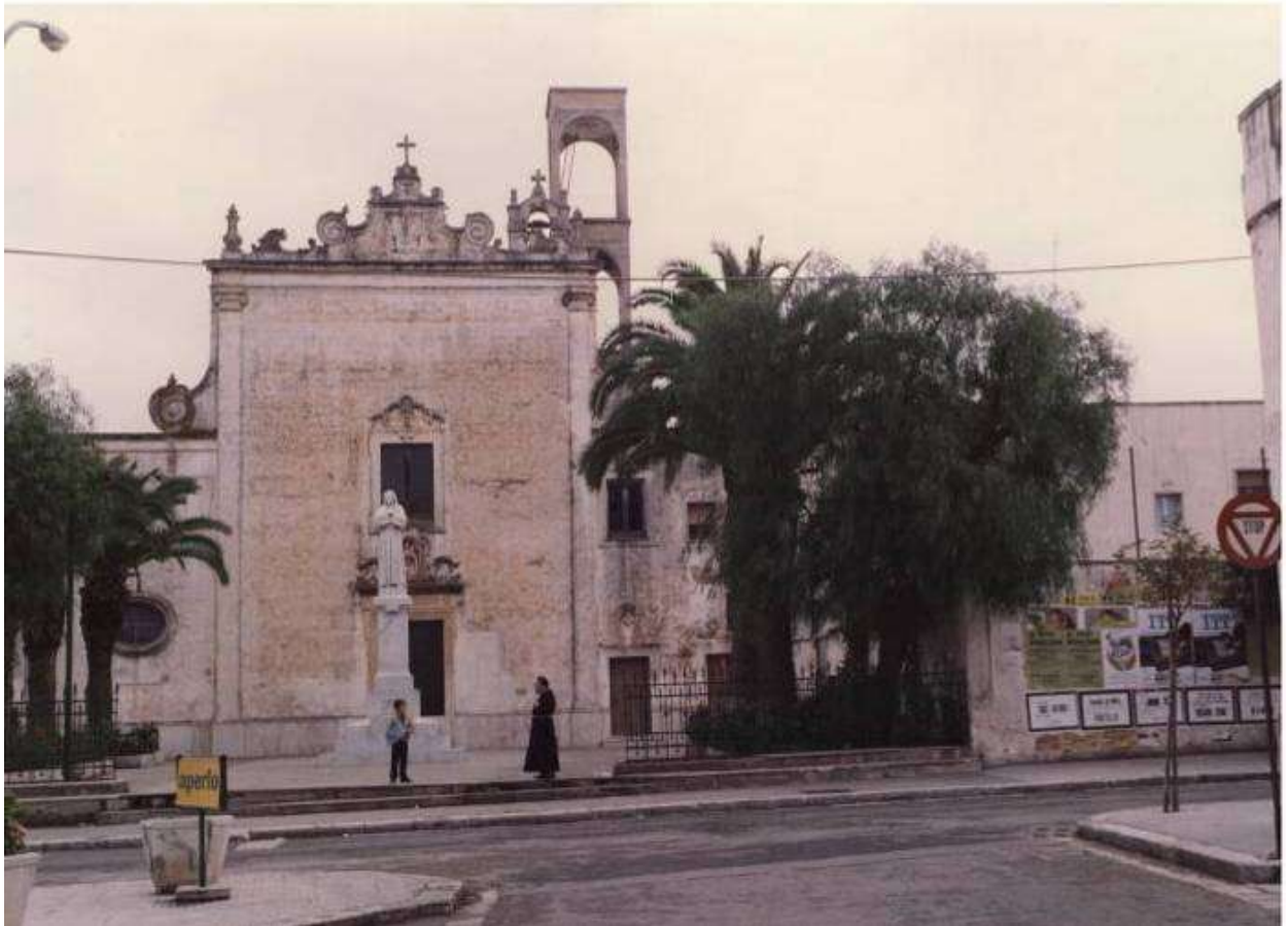
Facciata della chiesa dei cappuccini con il campanile costruito nel 1968
